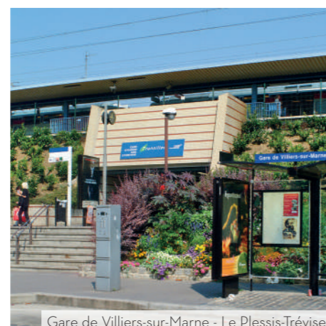
Gare de Villiers-sur-Marne - Le Plessis-Trévisé
